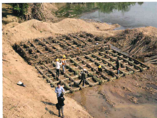
写真6 カーン川の河床に直接製作される粗朶沈床
