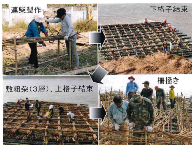
写真4 水上施工による粗朶沈床の製作手順
