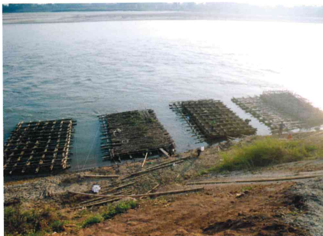
写真5 次々と水上で製作される粗朶沈床
