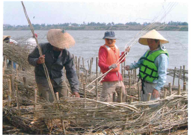
写真1 粗朶技術専門家による指導状況（フェーズ1）
