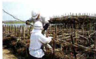
▲川床に埋める「粗朶沈床」を組む作業。熟練した職人が二人がかりで行う。
