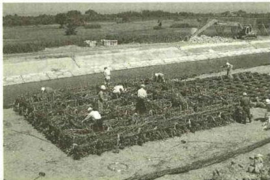
信濃川で粗朶沈床の組み立て
