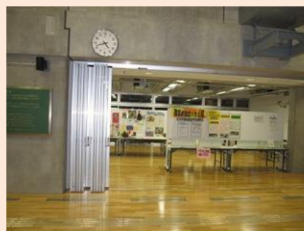
開放部分を仕切るための装置（立川市）
