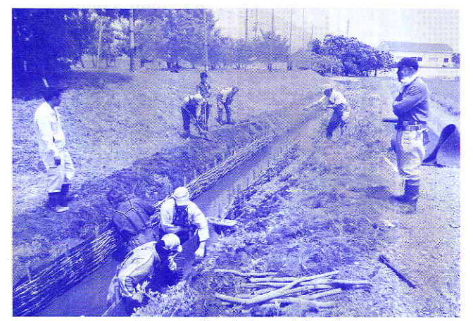
昨年に引き続き実施した護岸工事
