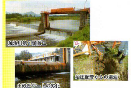
ダム電気設備の劣化
