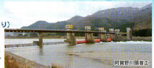
阿賀野川頭首工
