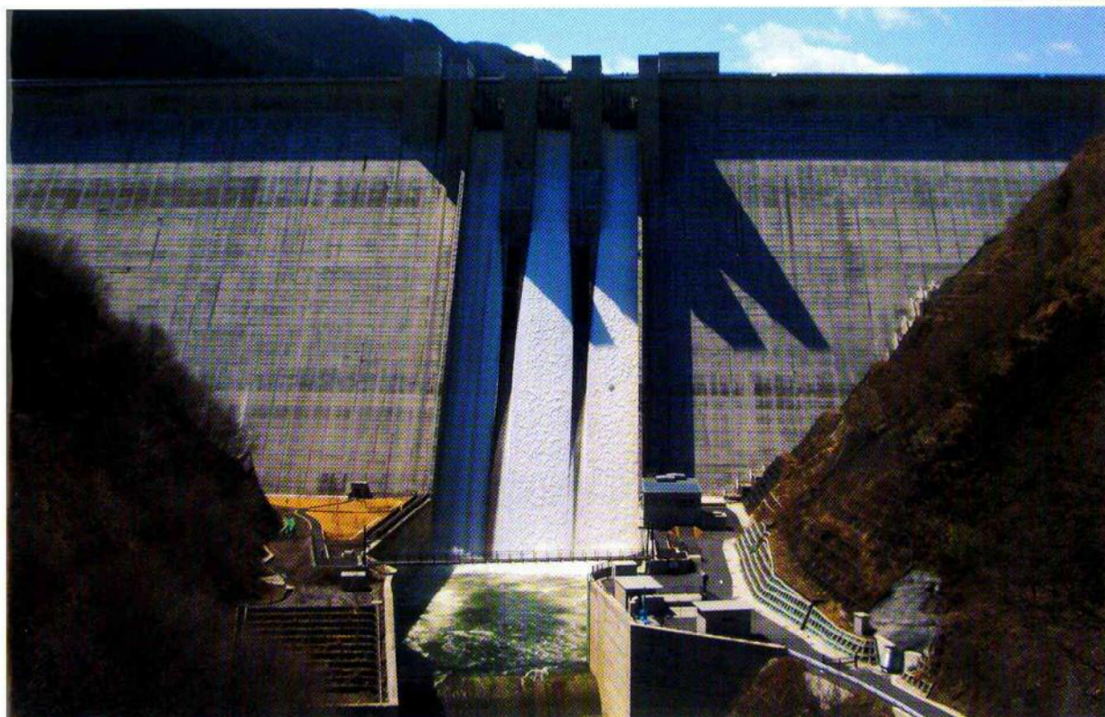
水資源機構・滝沢ダム
