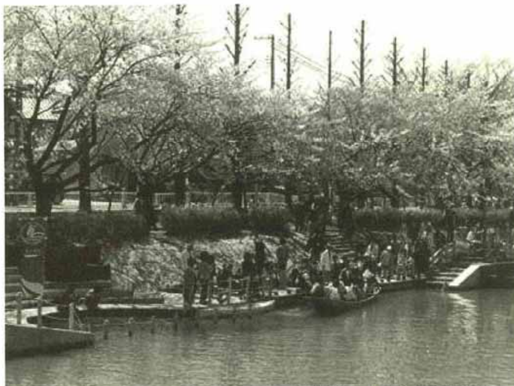
写真2・フェンスが30mだけ取り外された状況での栗ノ木川さくら祭り（2006年4月23日）
