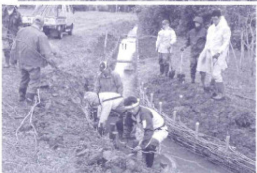
▲柵の支えとなる管の打ち込み ◀カーブの部分は粗朶柵で
