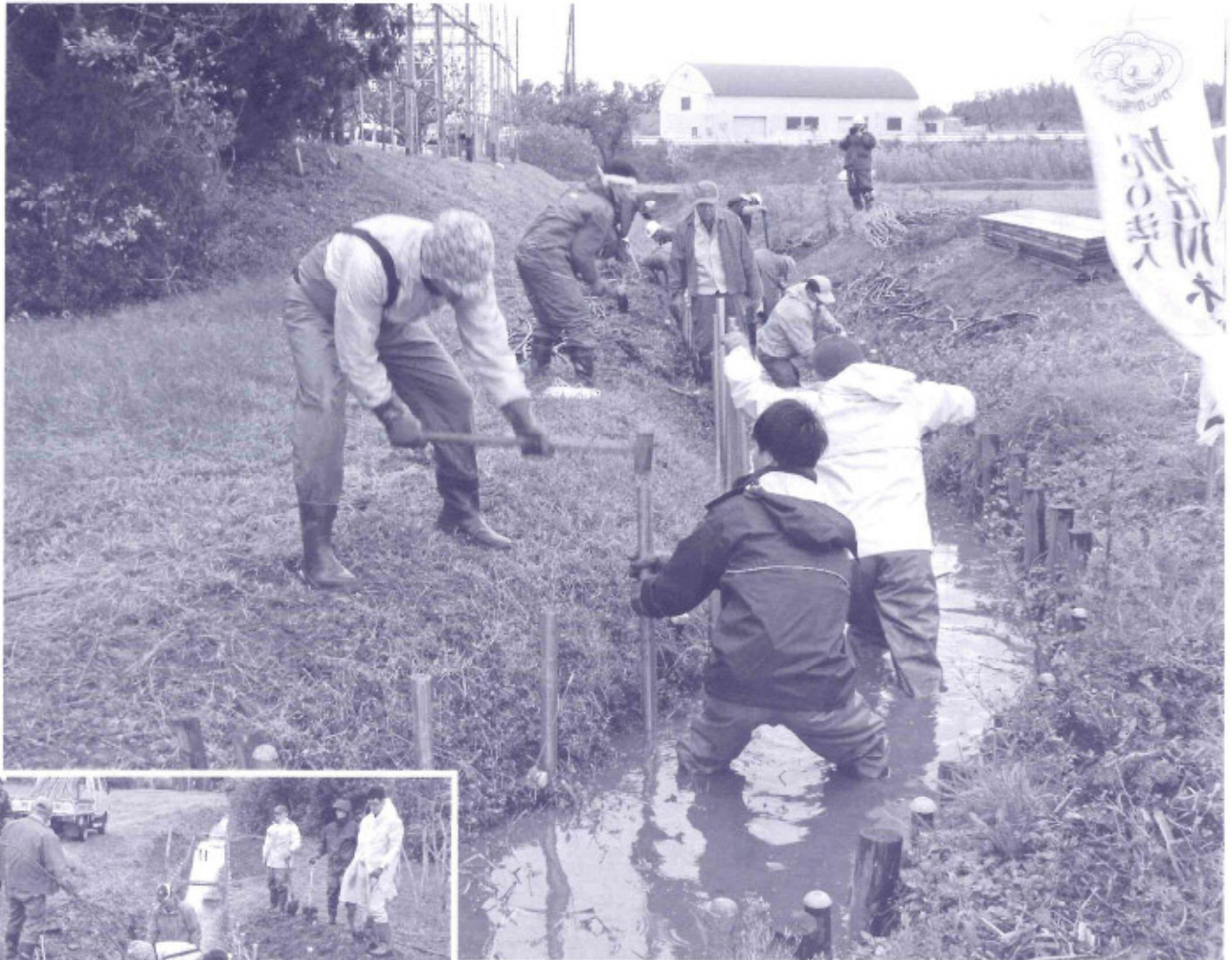
▲柵の支えとなる管の打ち込み ◀カーブの部分は粗朶柵で
